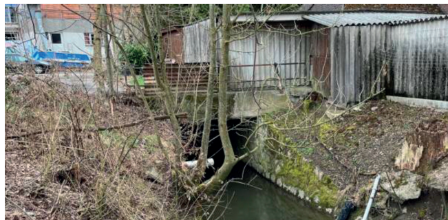
Besserer Schutz des rechtsseitigen Ufers (4)
