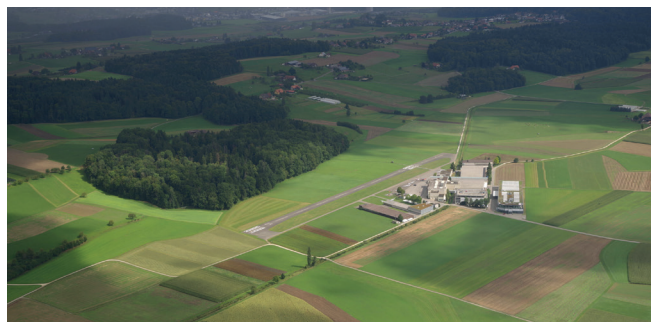
Verlegung der Altache im Bereich des Flugplatzes (3)
