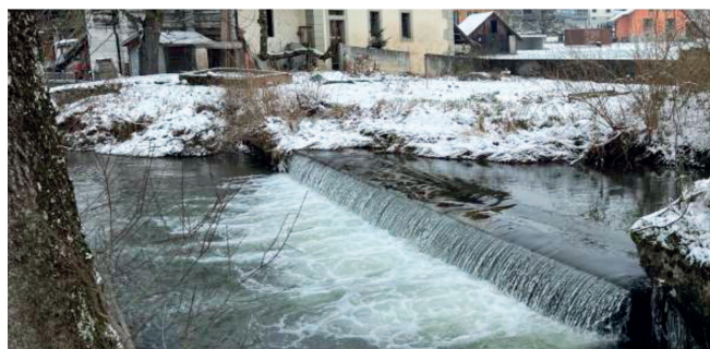
Rückbau der Schwelle (5)
